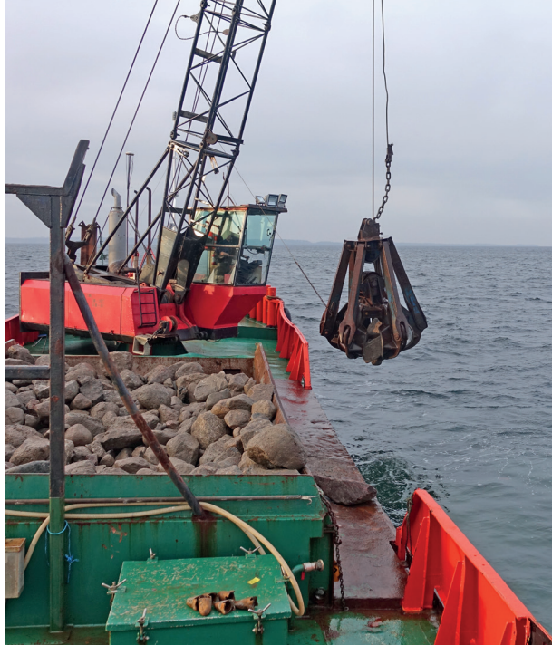
Udlægning af stenrev ved Als.
